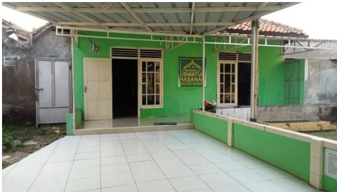
Gambar 6. Tk Mushala Uswatun Hasanah (Sarana Prasarana Kayu Bongkok)
