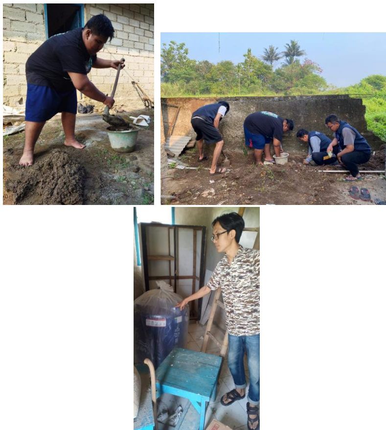
Gambar 4.13: Pembangunan Tempat Wudhu
