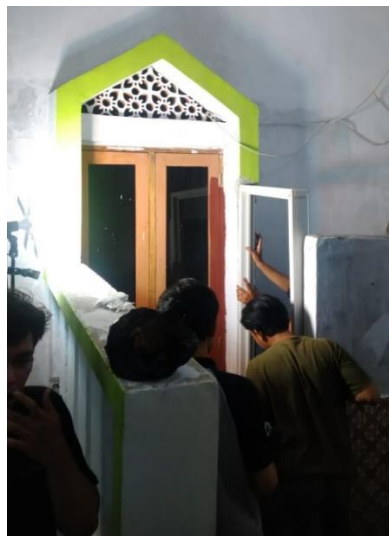
Pemasangan Pintu Kamar Mandi Masjid al-Muhazirin
