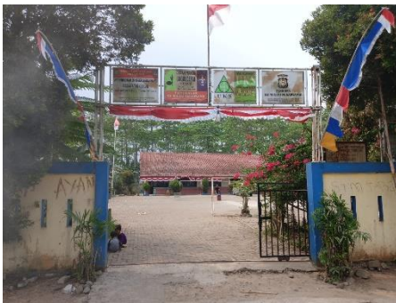
Gambar 8: SD Negeri Mekarwangi, Desa Mekarwangi, Kecamatan Cisauk, Kabupaten Tangerang
