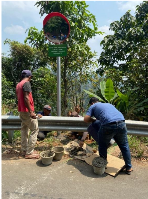
Proses Pemasangan Kaca Cembung
