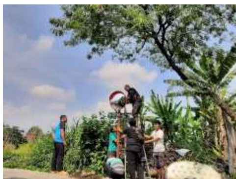
Gambar 4.9 Pemasangan Kaca Cembung
