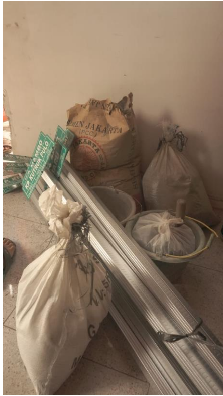
Gambar 4. 9 : Before Pemasangan Papan Jalan
