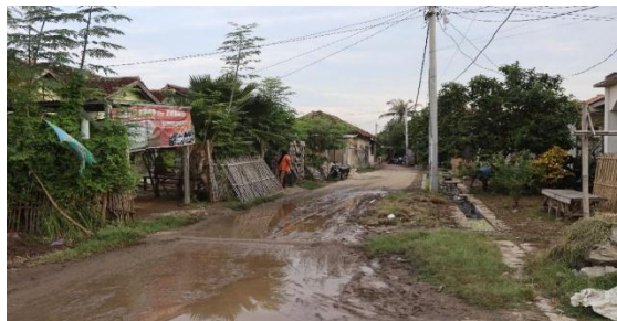
Gambar 3.7 : Kondisi Jalan Desa
