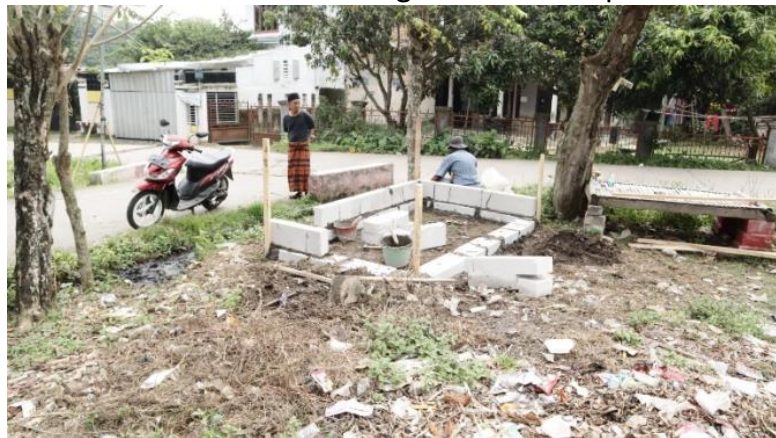
Proses Pembangunan Bak Sampah di Kp. Pulo Gede
