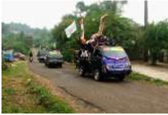
Gambar 3.4: Kondisi Jalan Desa Cibungur
