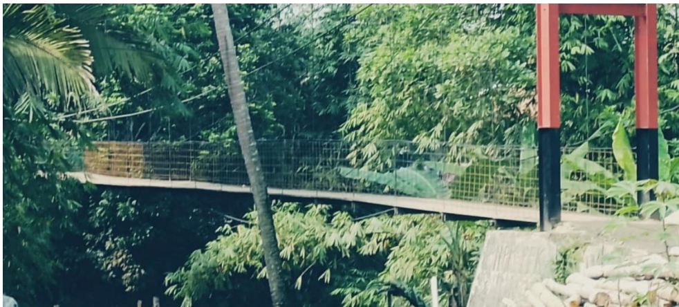
Gambar 3.12 Jembatan Kp. Kaduguling – Kp. Mekarmulya
