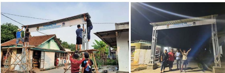
Gambar 4.13 : Kegiatan Pelayanan Pembangunan Gapura
