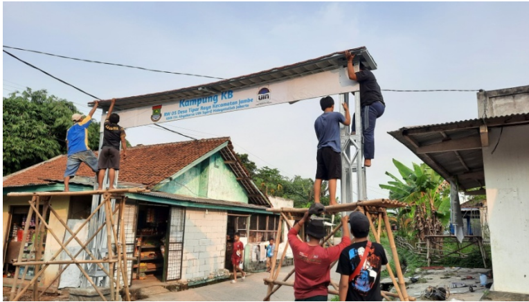
Pembangunan Gapura Kampung KB RW 05
