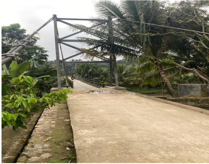
Gambar 3.4 Jembatan Gantung di Kampung Kahleker
