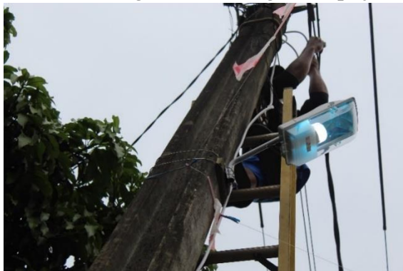
Gambar 4. 4 Hasil Program Pemasangan Lampu Jalan
