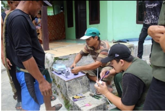
Gambar 4. 3 Kegiatan Pemasangan Lampu Jalan
