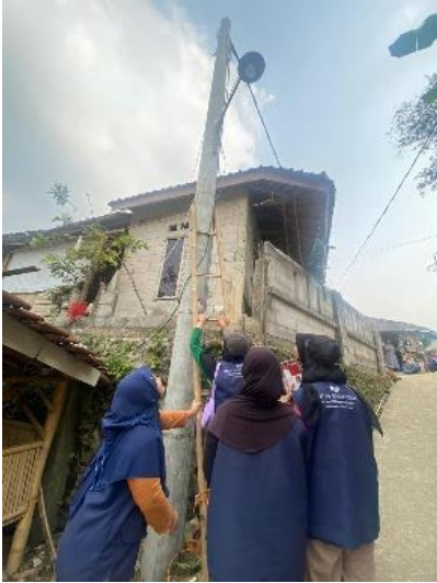
Proses pengadaan dan pemasangan lampu di Desa Ciasmara
