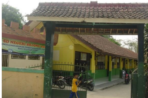
Gambar 3. Gedung SDN Bojong Loa 1
