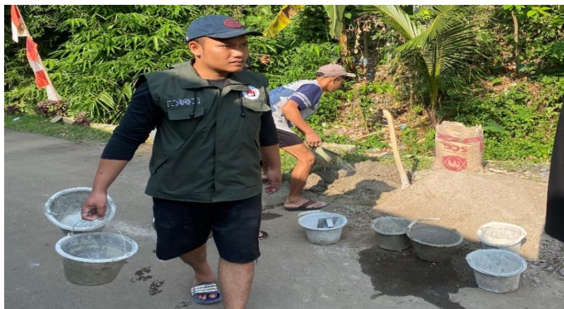
Gambar 4.7 Pembangunan Bank Sampah
